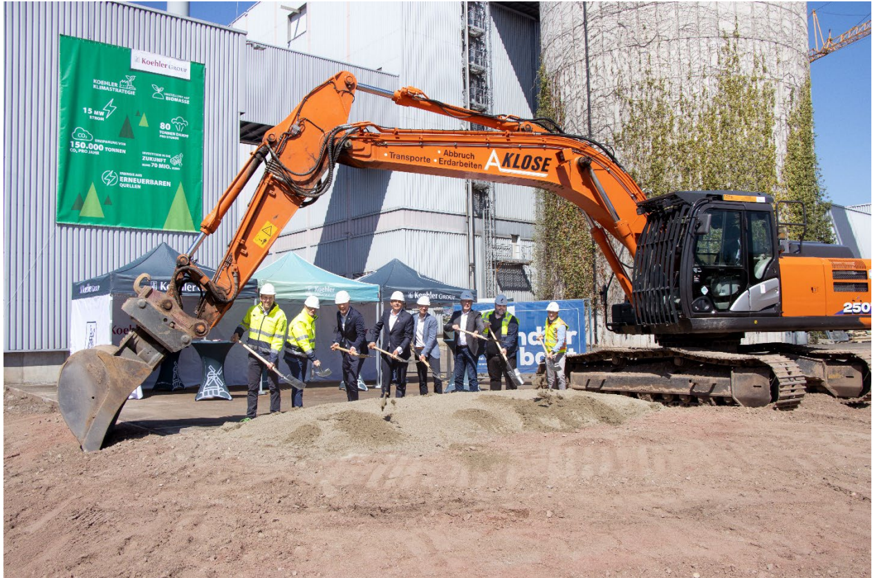
Bildunterschrift: Feierlicher Spatenstich für 70 Millionen Projekt; v. l.: Michael Trautmann, Bereichsleiter Zentrale Anlagentechnik – Koehler Innovation & Technology, Hartmut Felsch – Werkleiter Koehler Paper Standort Oberkirch, Dr. Stefan Karrer – Vorstand Technik Koehler-Gruppe, Kai Furler – Vorstandsvorsitzender der Koehler-Gruppe, Christoph Lipps – Bürgermeister Stadt Oberkirch, Markus Huber – Rendler Bau GmbH, Björn Stuba – SPB Ingenieure, Andreas Bächle – Rendler Bau GmbH Bildrechte: Koehler-Gruppe
